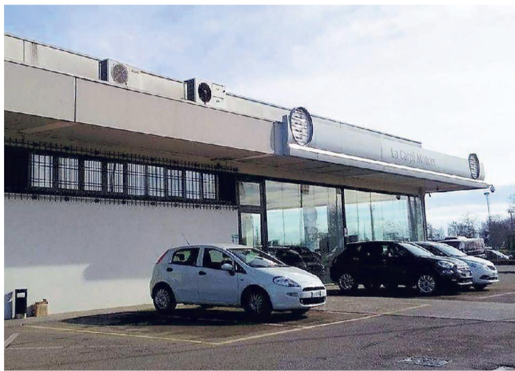
La concessionaria La Carpi e l'impronta delle insegne Fiat rimosse nei giorni scorsi da tutti i punti dell'edificio
